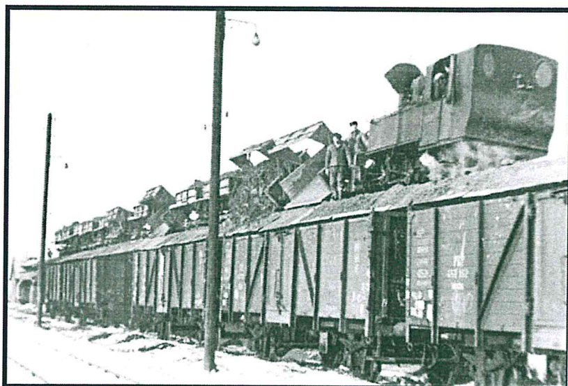
A korabeli fotón láthatjuk, hogyan történt az átrakás Bodajkon a kisvasúti kocsikból a nagyvasúti kocsikba
