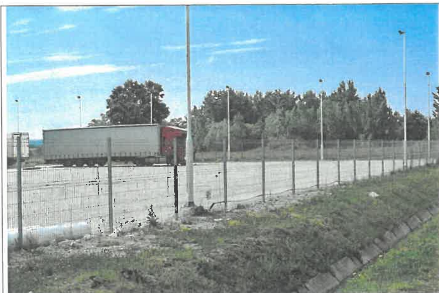
A 2146/51 hrsz-ú telken kialakított kamion parkoló
