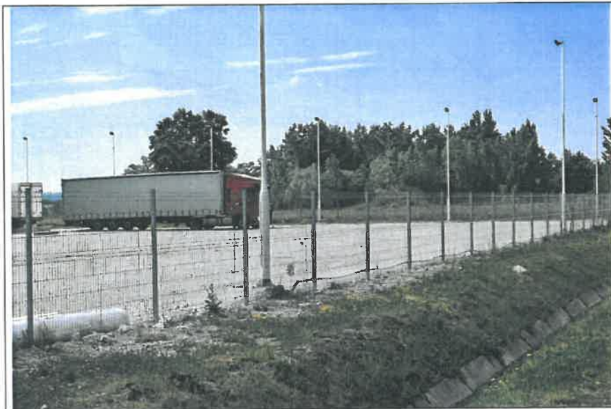
A 2146/51 hrsz-ú telken kialakított kamion parkoló
